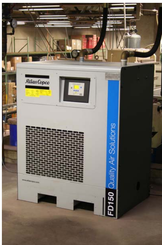
Der Kältetrockner FD 150 wird im Wechsel an den jeweils laufenden Kompressor angeschlossen. Mit seiner modernen Steuerungstechnologie lässt sich der Drucktaupunkt der Druckluft optimal an die Umgebungsbedingungen anpassen. (Bild: Atlas Copco Kompressoren und Drucklufttechnik GmbH)
